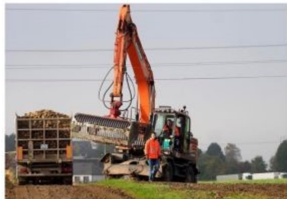
Des grues chargent la remorque des poids lourds. Les engins de levage sont là aussi pour dépanner parfois, lorsque le camion est coincé sur un sentier trop gras.
